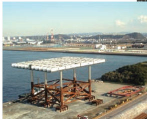
羽田新滑走路の完成予想パース 左の写真のテーブル状のもの（ジャケットと呼ばれる）が新滑走路島（右図）に198基ずつけられ、新滑走路の約1/3の平面をつくります。
