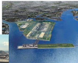
羽田新滑走路の完成予想パース 左の写真のテーブル状のもの（ジャケットと呼ばれる）が新滑走路島（右図）に198基ずつけられ、新滑走路の約1/3の平面をつくります。
